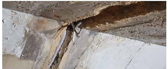
DESOI Quick Seal setzen, beginnend mit dem Rechteck-Stahlpacker Set DESOI Quick Seal, starting with the rectangular steel packer
